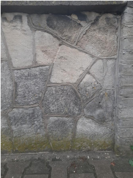
Detal spoin i kamieniarki - przęsło dobrze zachowane, przeznaczone do konserwacji
